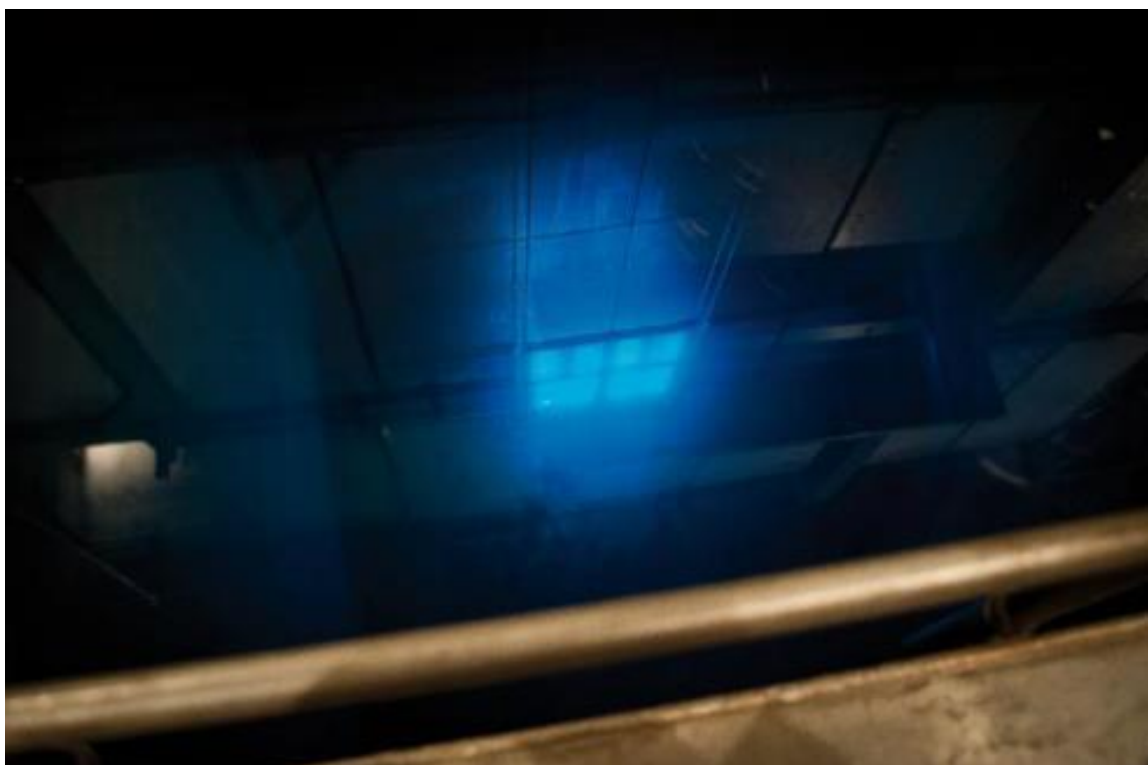
Sursa de radiarii gamma (Cobal-60: 1.17 MeV,1.33 MeV) in piscina iradiatorului IRASM
