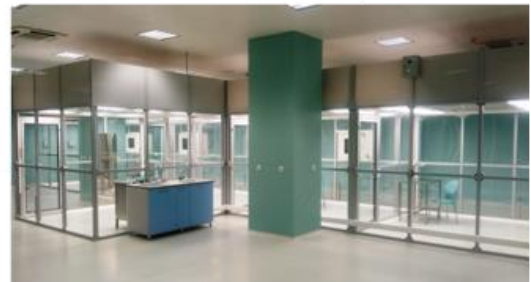
Configuratia Ansamblului de Camere Curate Modulare Mobile/Movibile la instalare
